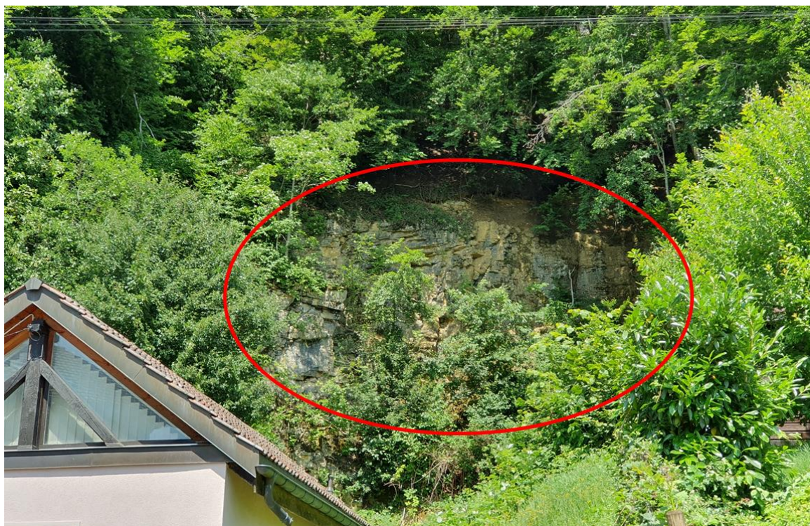
Figure 9 : Affleurement de calcaires des falaises de la Grange du Dîme, en amont d'une parcelle située en zone à bâtir.
