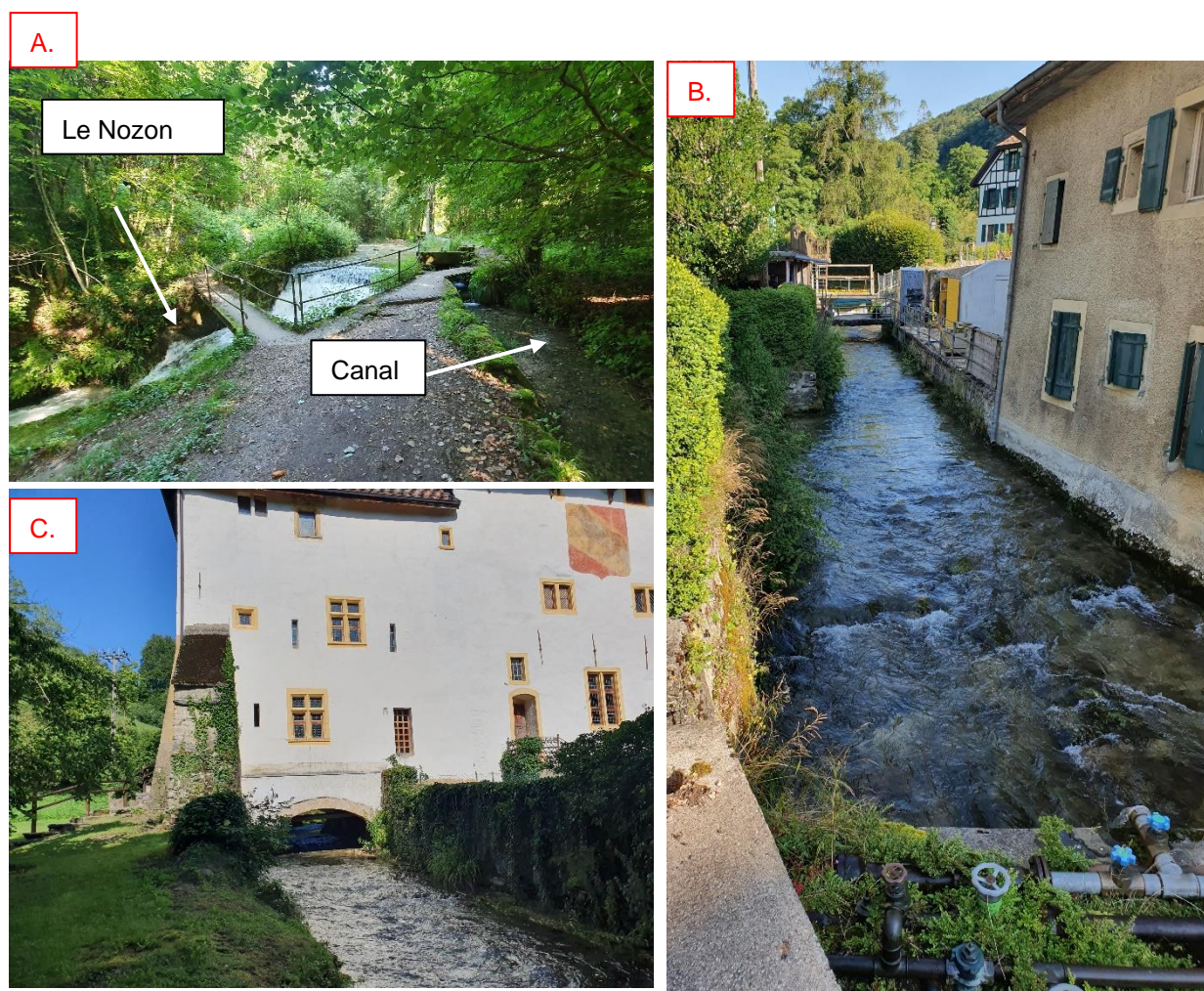
Figure 2 : Rivière Le Nozon, traversant la commune de Romainmôtier : Photo A. canal-; Photos B et C : ouvrages de faible (B) et moyenne (C) dimensions pouvant s'obstruer pour des événements Tr100 et respectivement Tr300.
