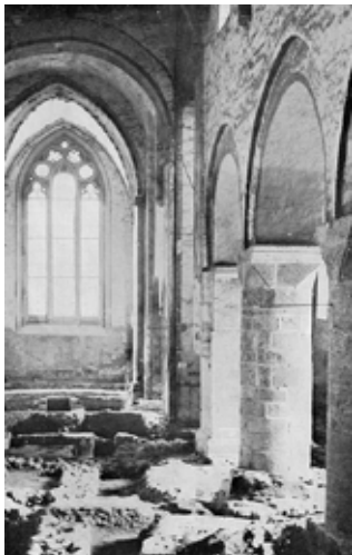
Der Chor der Kirche während der Restaurierung von 1899-1915
