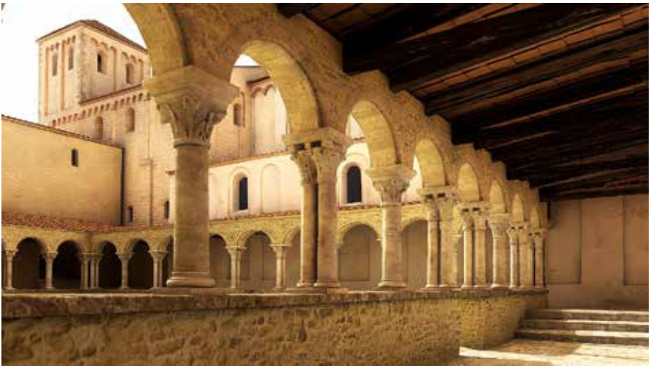
Der romanische Kreuzgang (Rekonstruktion)
