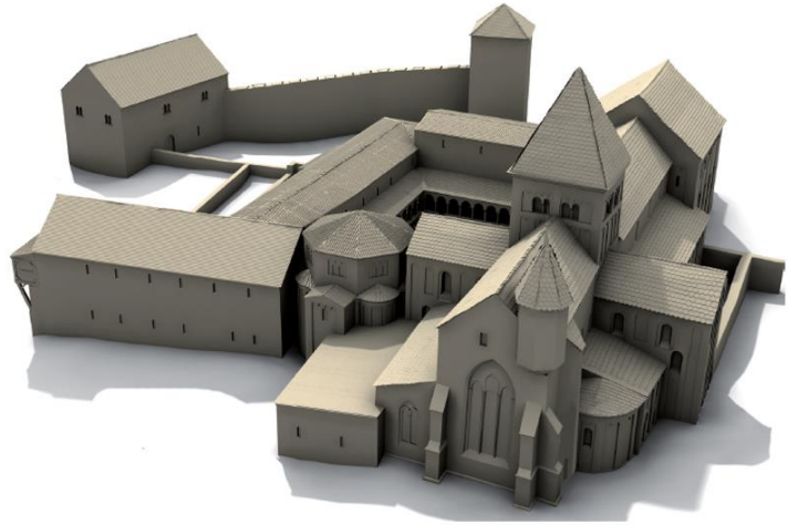
Le monastère avant le deuxième incendie, les tours de l'avant-nef ne sont pas reconstruites, l'abside centrale romane a laissé la place à un sanctuaire gothique
