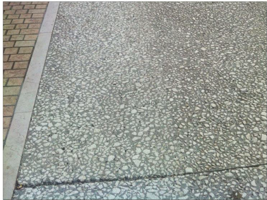
Exemple de béton désactivé Lyon, France
