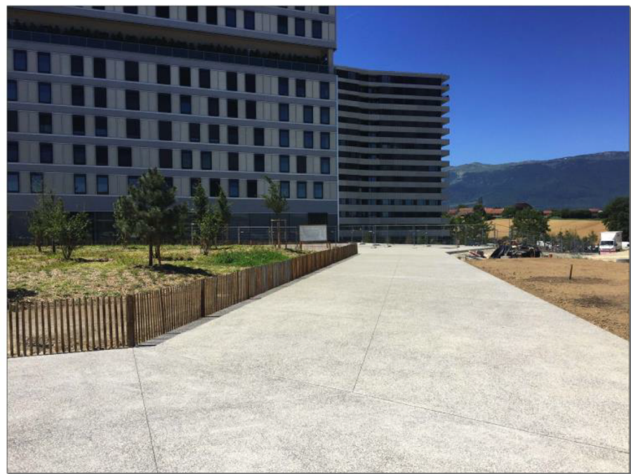
Exemple béton désactivé Les Vergers, Genève, Suisse
